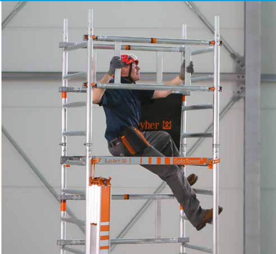
**El modelo SoloTower es una pequeña torre móvil de montaje sencillo y seguro, por una sola persona, para altura de trabajo de 6,15 m.**
