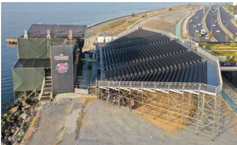
Escenario y grada montados con componentes estándar del sistema Allround y del sistema EV.
