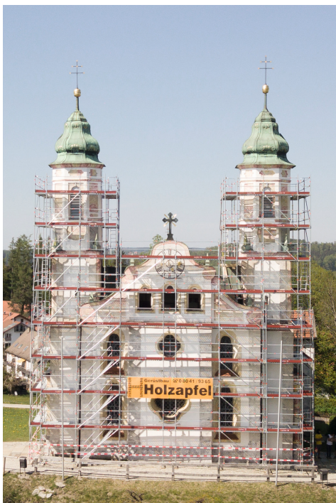
Reparación de iglesia.
