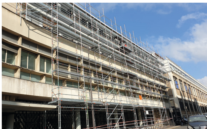
Reparación de fachada.
