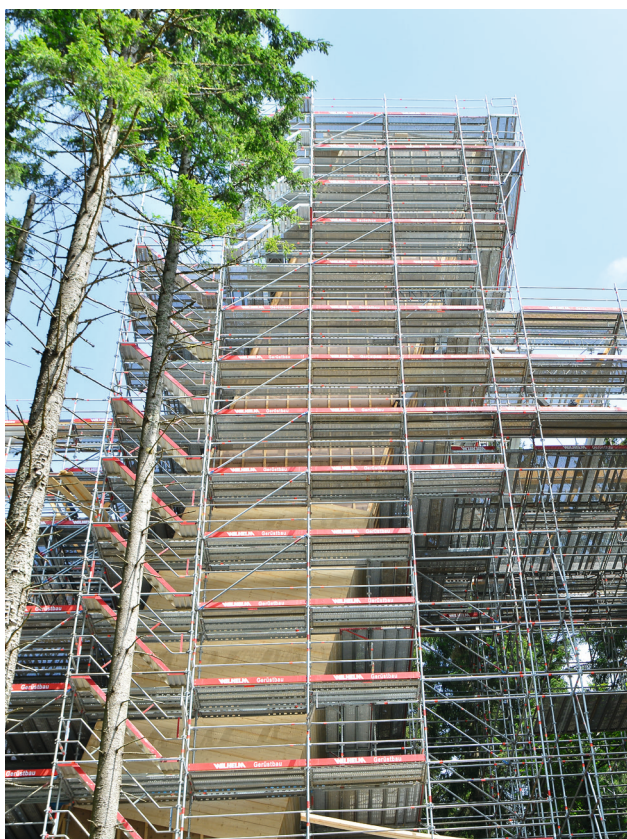
Construcción de edificio con estructura de fachada inclinada.
