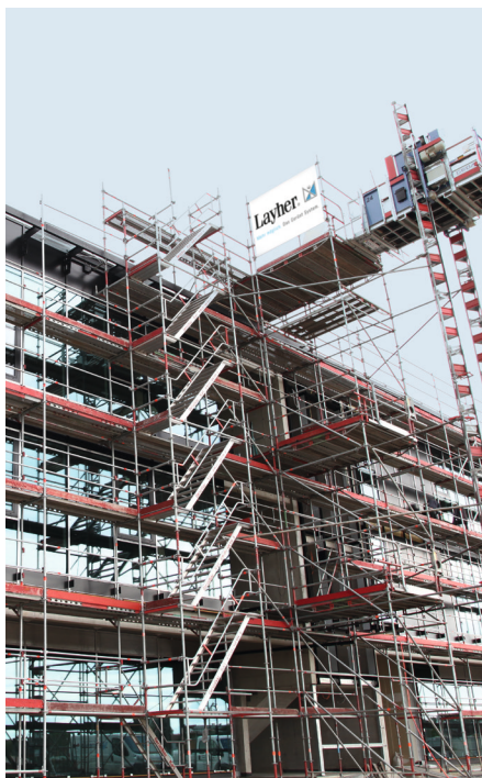
Construcción de edificio con torre de acceso para montacargas.
