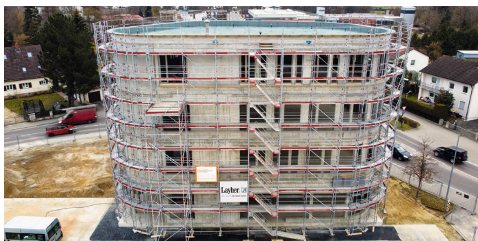
Construcción de edificio con geometría ovalada.
