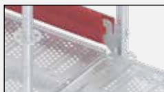
Montaje de rodapié de madera.
